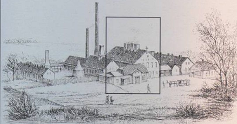
Geburtsstätte des nahtlos gewalzten Stahlrohres · Ansicht um 1885
